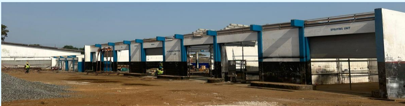
現在進行中のGTI Kissyにおける改修工事の様
